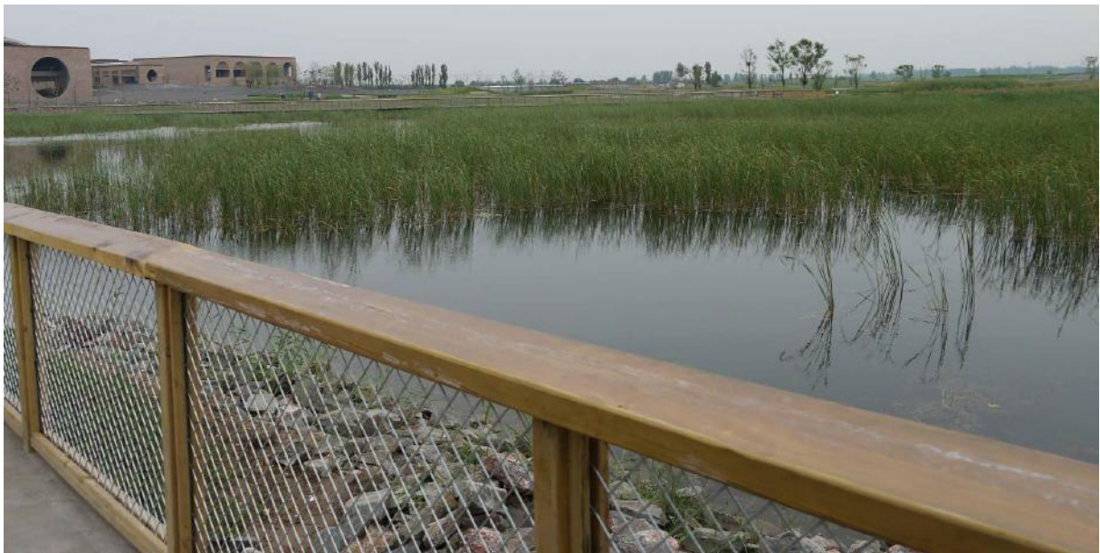
Figur 4-3 Nyanlagd dagvattendamm och våtmark och en del av en hantverksby i bakgrunden
