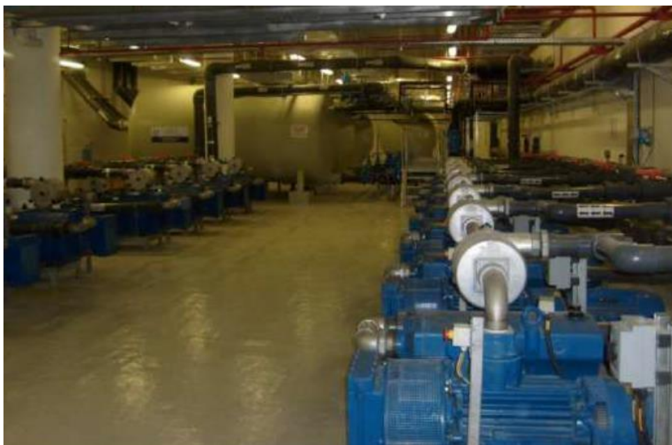
Figur 4-7. Exempel på vakuumsstation från Roediger.
